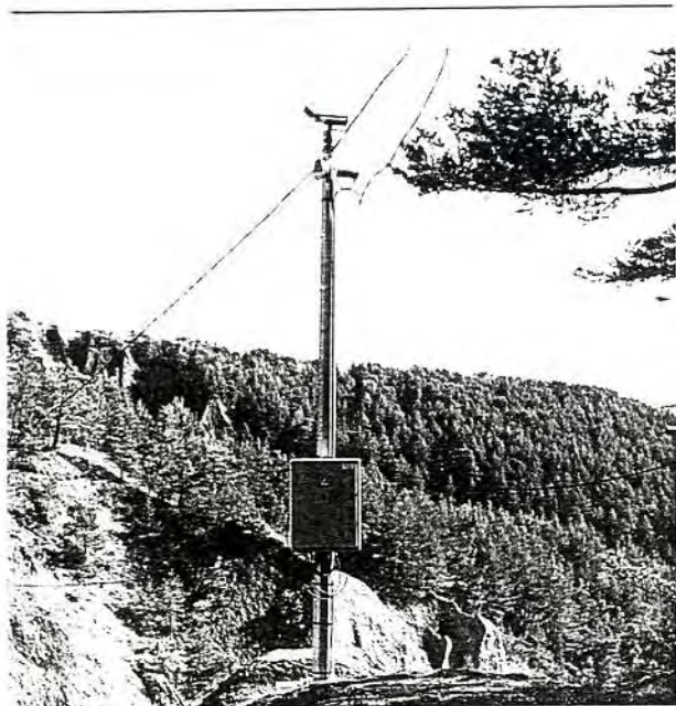
Fig. 8 - Caméra de surveillance de la coulée.
